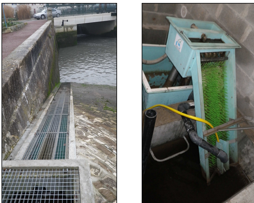
Figure 44 : Passe extérieure avec substrat de reptation et piège
