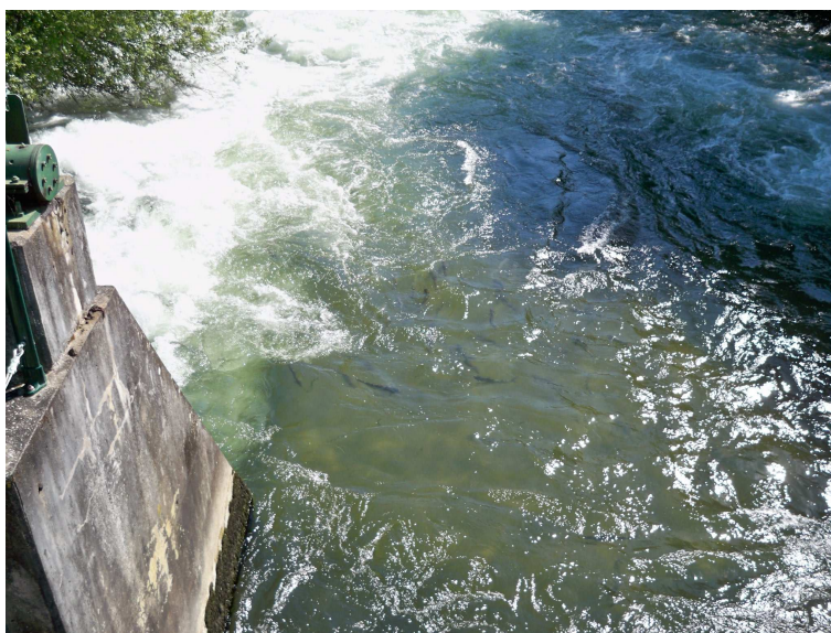
Figure 12 : Aloses bloquées en aval de l'ouvrage de Bagnolet (photo : F.ALBERT)
