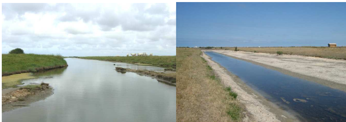
Figure 82 : F1 en eau et à moitié à sec avant le curage d'août 2010 (zone de plat sur le côté) (photo : E. BUARD)
