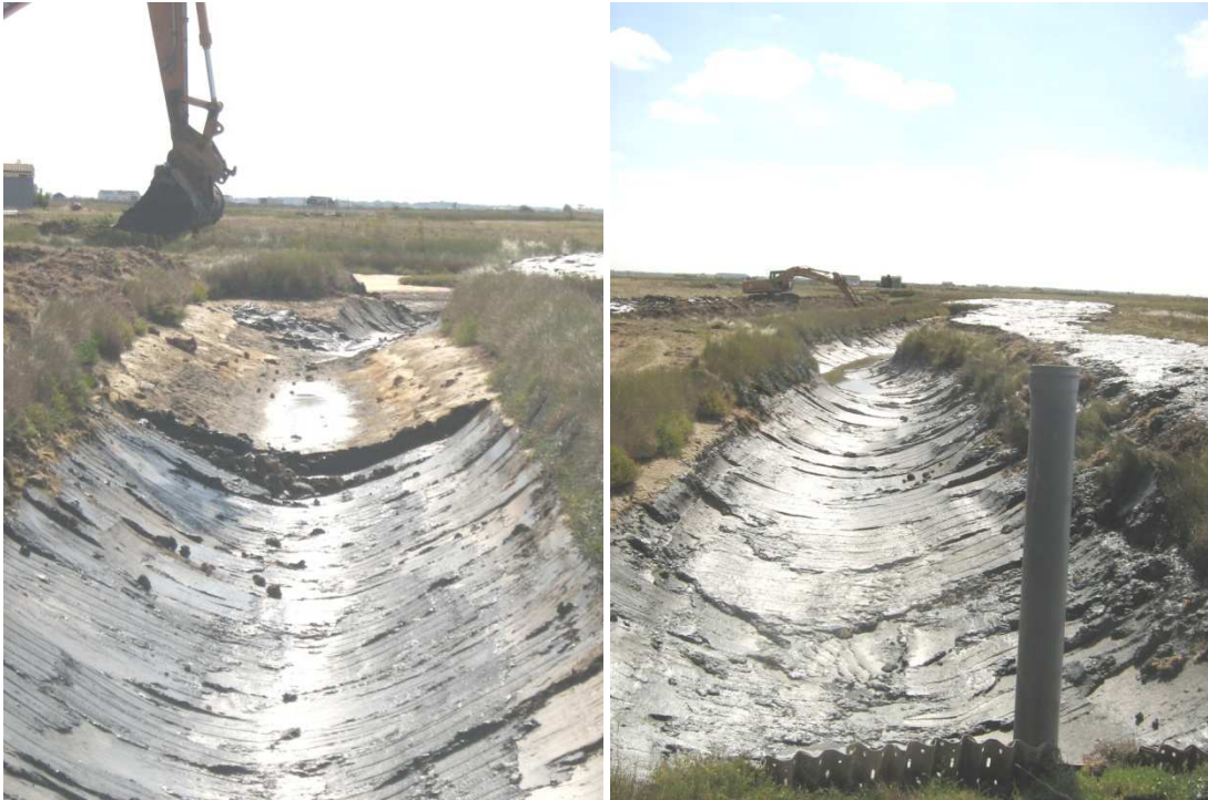
Figure 89 : Fossé F2 pendant le curage (entrée du fossé) (photo : E. BUARD)
