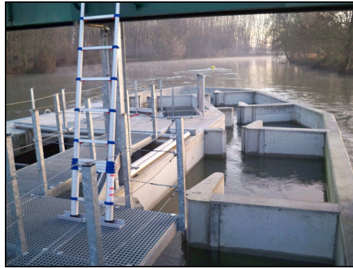
Figure 25 : Passe à poissons sur le barrage de Crouin (photos : F. ALBERT, A. POSTIC-PUIVIF)
